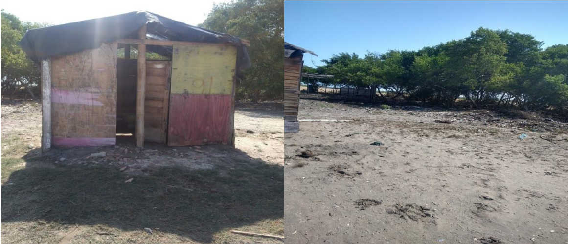
Figura 2.224. Baño público de estaderos – Sector de Puerto Mocho – Las Flores
