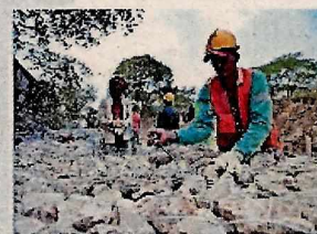
Suministro e instalación de gaviones
