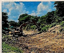
Limpieza de canal de material orgánico – desalojo de material
