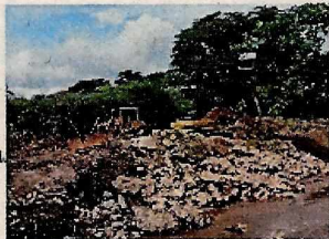
Desalojo de empedrado existente demolido
