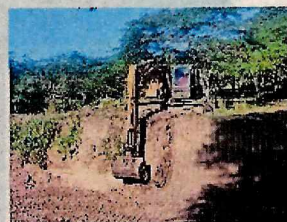
Excavación a máquina para perfilamiento de talud.
