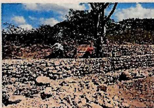
Suministro e instalación de gaviones
