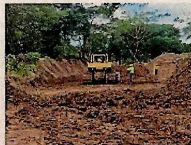
Excavación a máquina de fondo
