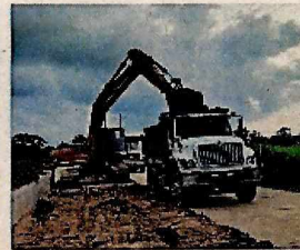
Limpieza de canal de material orgánico – desalojo de material
