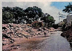
Desalojo de empedrado existente demolido
