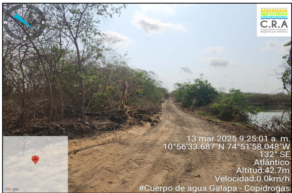
Imagen N° 3 – Aprovechamiento forestal construcción carretable, C.R.A
