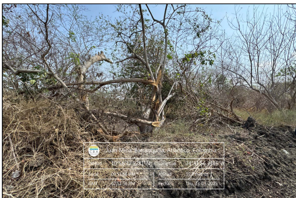
Imagen N° 4 – Aprovechamiento forestal construcción carretable, C.R.A
