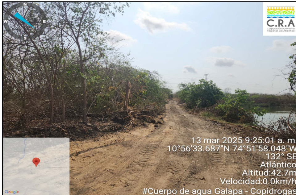
Imagen N° 3 – Aprovechamiento forestal construcción carretable, C.R.A
