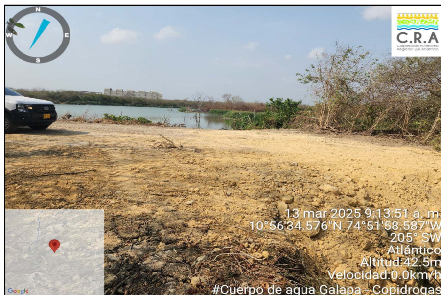
Imagen N° 8 – Taponamiento de canal con material de cantera, C.R.A
