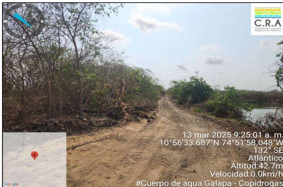
Imagen N° 3 – Aprovechamiento forestal construcción carretable, C.R.A
