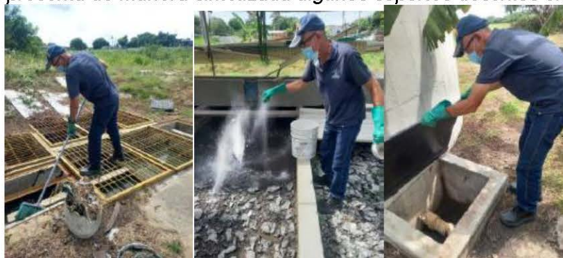
Ilustración 1. Actividades de mantenimiento a la PTAR de CACOM 3.
