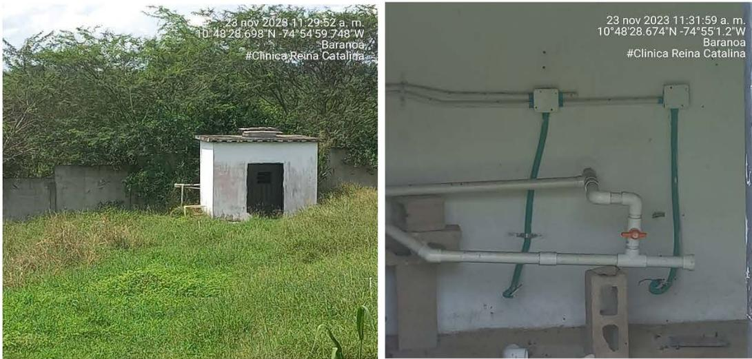
**Imagen 7 Captación de aguas subterráneas de Un pozo profundo, con sus coordenadas de ubicación.**
