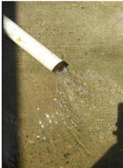
Se realizó retro lavado a las columnas de Carbón activado y multimedia y se lavaron tanques retirando todas las impurezas existentes 27/06/2023
