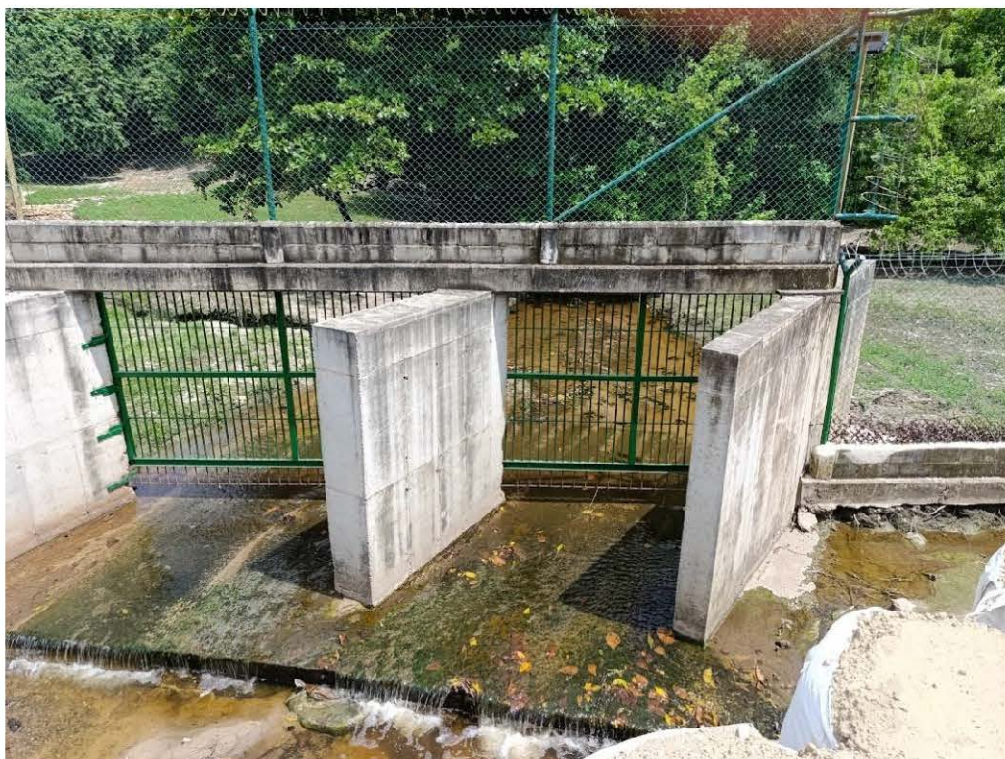
Fotografía 1 intervención del cauce para la instalación de la rejillas.
