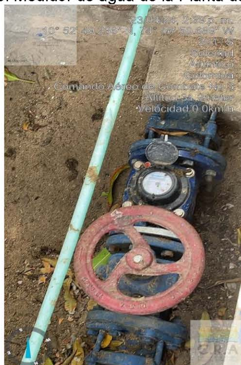
Fotografía 6. Medidor de agua de la Planta de tratamiento
