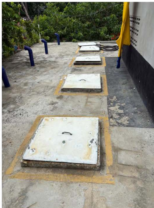
Foto N° 2 Fecha: 3 de julio de 2025. Ubicación: Urbanización Lomas de Caujaral Observaciones: Tanques del proceso de tratamiento.
