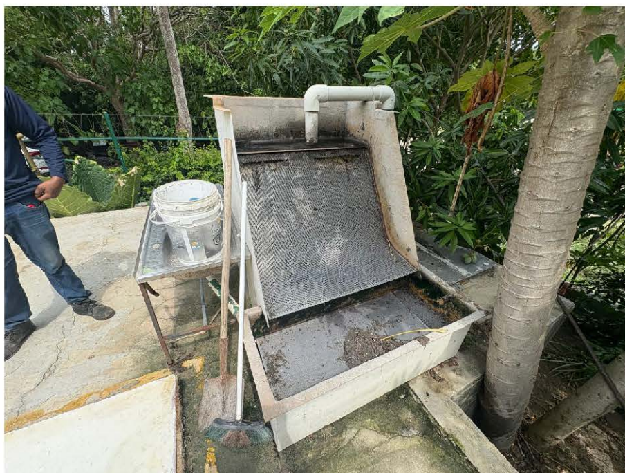
Foto N° 1 Fecha: 3 de julio de 2025. Ubicación: Urbanización Lomas de Caujaral Observaciones: Criba de separación.
