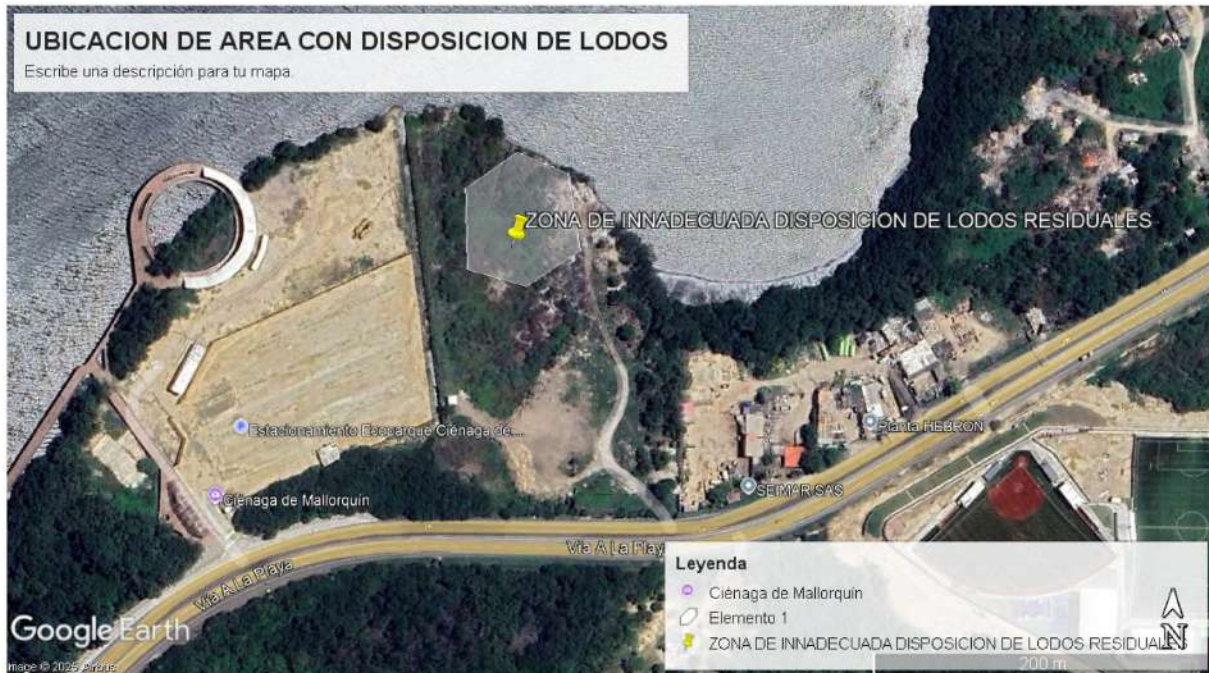
Imagen 1: Ubicación de la zona de inadecuada disposición de lodos.
