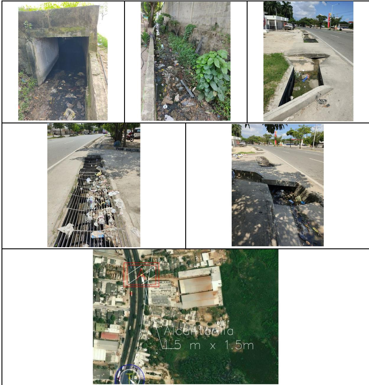
**Figura 121. Alcantarilla aguas lluvias 1.5 X 1.5.**
