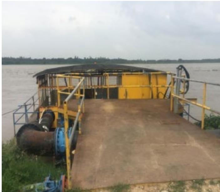
**Fotografía 6. Bocatoma – planchón sobre el río Magdalena. Aguas de Malambo S.A. E.S.P.**
