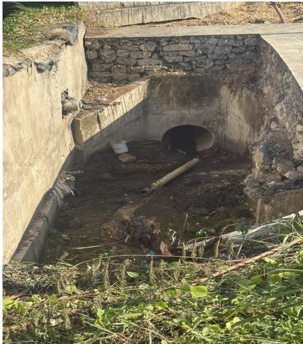
Foto N° 2 Fecha: 17 de julio de 2026 Ubicación: Box Culvert. Observaciones: Box culvert finalizado con escorrentías de aguas lluvias.
