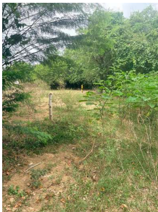
Foto N° 2 Fecha: 14 de septiembre de 2026. Ubicación: Punto de la ocupación de cauce jurisdicción de Luruaco Observaciones: obras de ocupación finalizadas.
