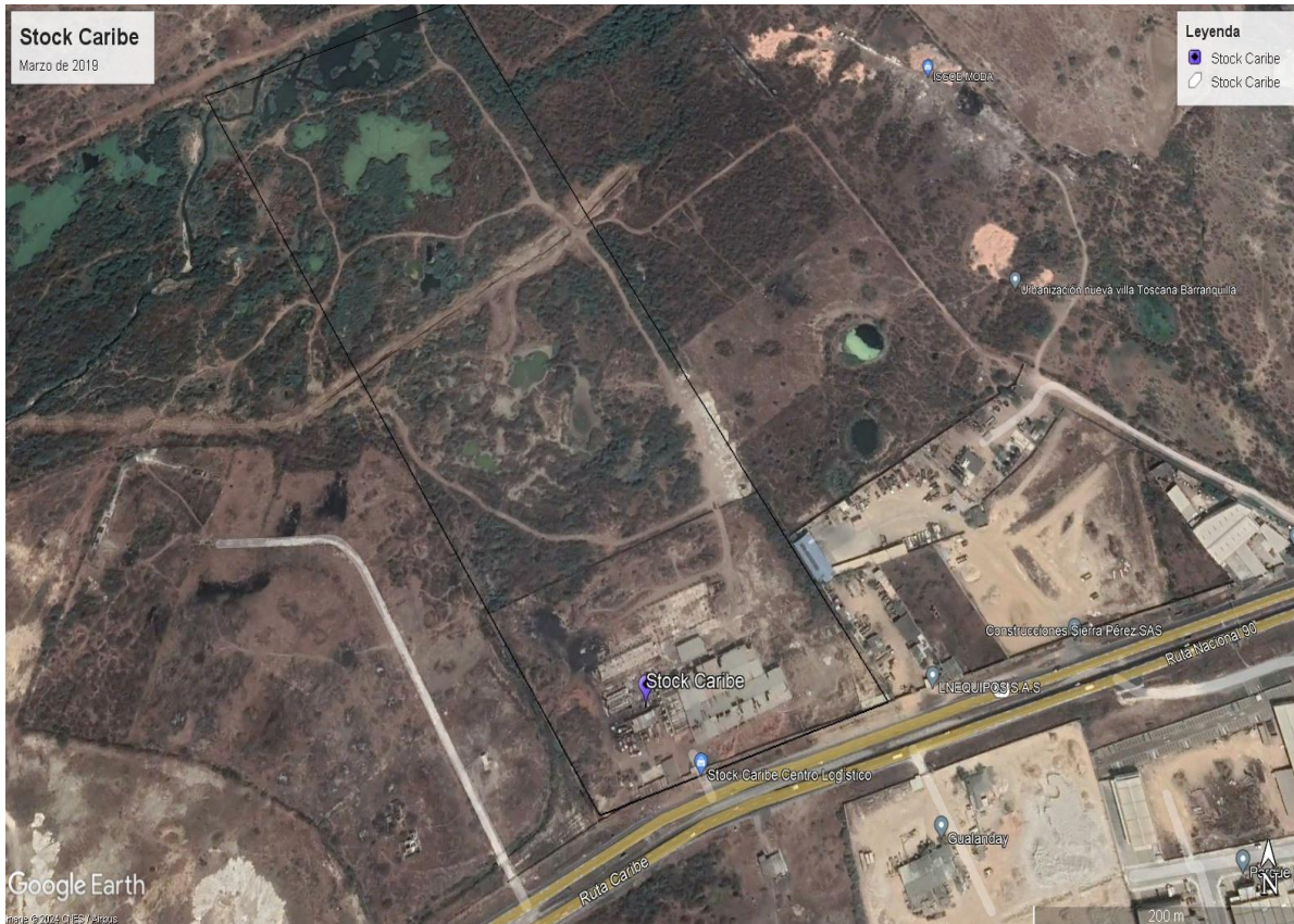
Imagen 4. Estado del lote en marzo de 2019, se ha iniciado la obra hidráulica sobre el Arroyo Caña
